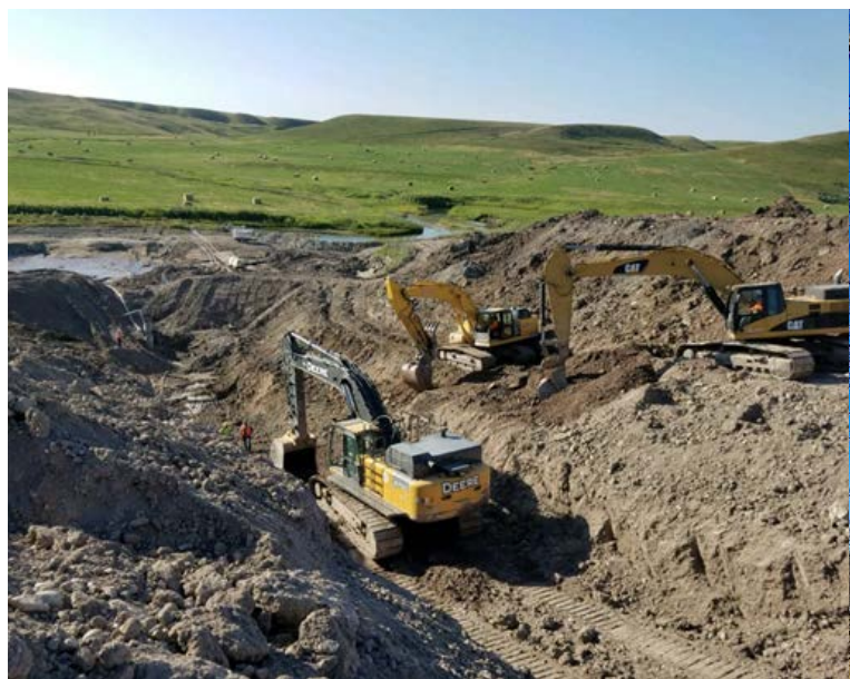
Le bassin de décantation Drop 5 dans le canal St. Mary, utilisé pour réduire la vitesse de l'eau, en cours d'excavation et d'assèchement. Source : John Kilpatrick
